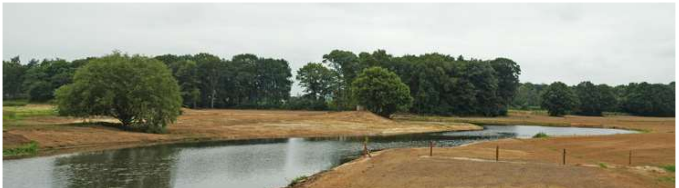
meanderende Regge met dijkrestand en trafo
